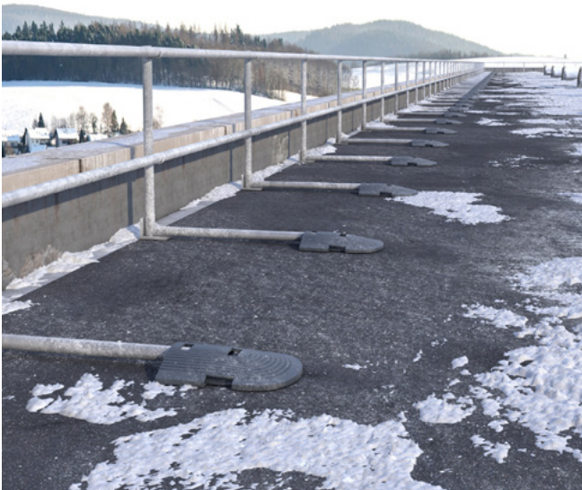
Abb. 14 Geländer an der Flachdachattika
