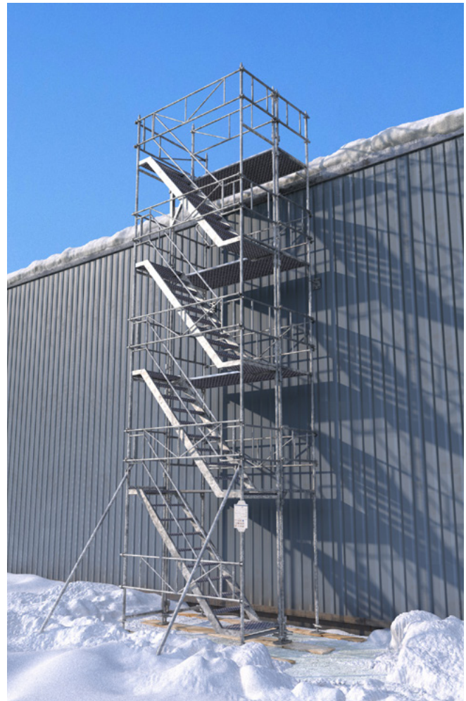
Abb. 12 Beispiel für einen temporär erstellten Treppenturm
