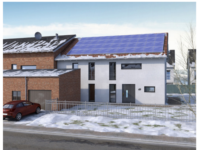
Abb. 20 Dachfläche ausgestattet mit einer Photovoltaikanlage
