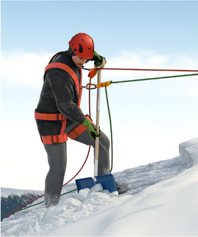
Abb. 5 Schneeräumung mit Schneeschieber
