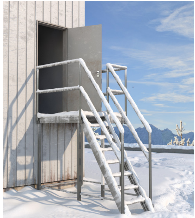
Abb. 10 Flachdachzugang von innen
