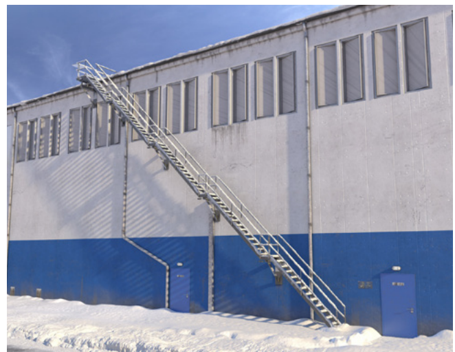
Abb. 11 Flachdachzugang über eine Außentreppe
