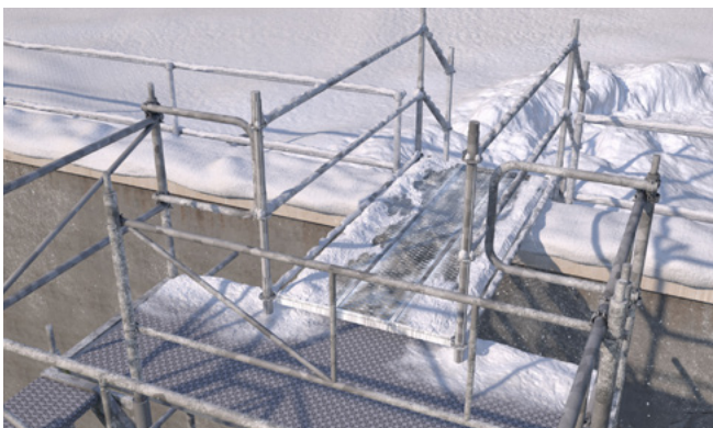
Abb. 16 Treppenturm mit Übergang zum Flachdach
